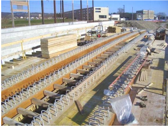
Abbildung 10: Trager und Verbindungselemente Flurweg
