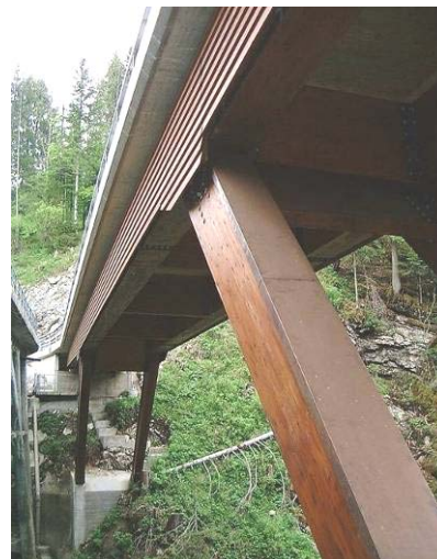
Abbildung 19: Die neue Brücke von unten
