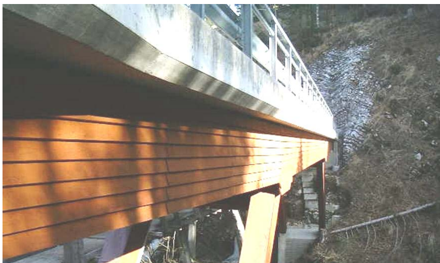
Abbildung 20: Die neue Brücke über die Hongrin in Allières
