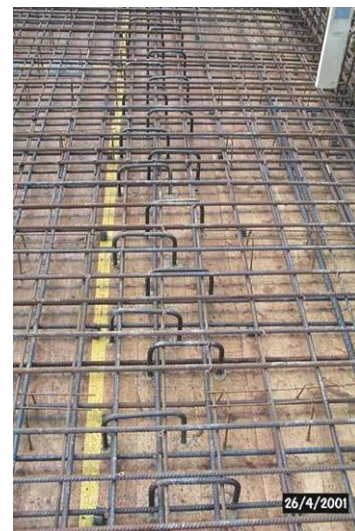
Abbildung 24: Bewehrung der Betonplatte
