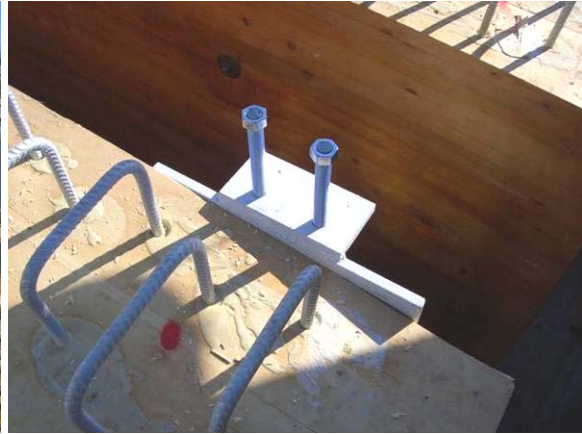
Abbildung 11: Ausschnitt Verbindungselemente Flurweg
