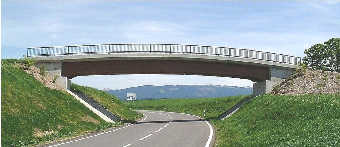
Abbildung 22: IVS-Überführung bei Posieux
