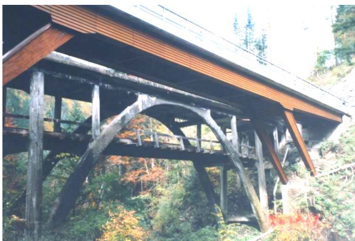
Abbildung 18: Die neue und alte Brücke über die Hongrin in Allières
