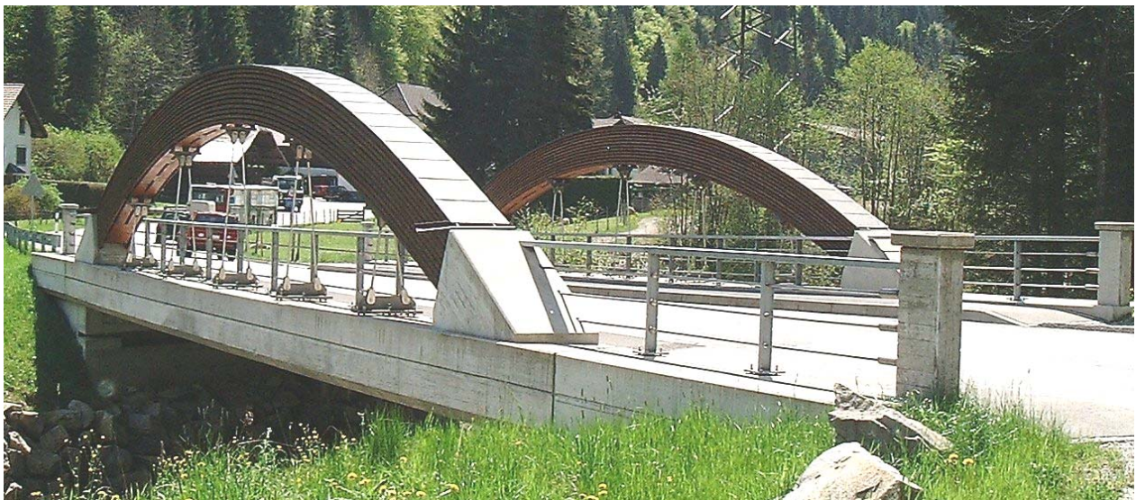
Abbildung 21: Brücke über die Sense in Zollhaus
