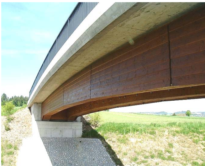
Abbildung 23: IVS-Überführung bei Posieux
