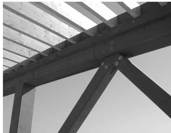
Abbildung 6: Konstruktion aus Kombination Nadelholz und tropischem Hartholz (Bongossi)
