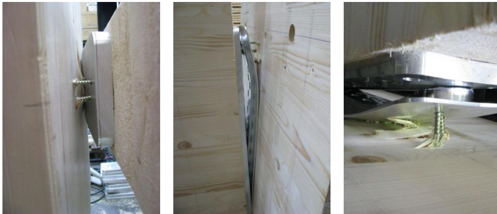
Abbildung 14: Bruchbilder – Beanspruchungsart 2; Ausziehen der oberen MomS im HT (li.); wie vorher jedoch mit Ausziehen des „Kopfes“ der Verbindung (Mitte); Detail der ausgezogenen MomS und des „Kopfes“ (re.)
