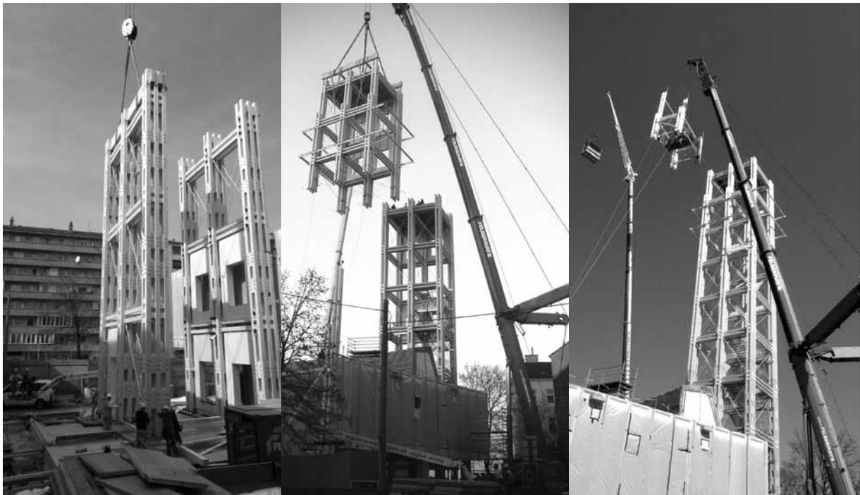
Abbildung 18: Montage der Turmmodule
