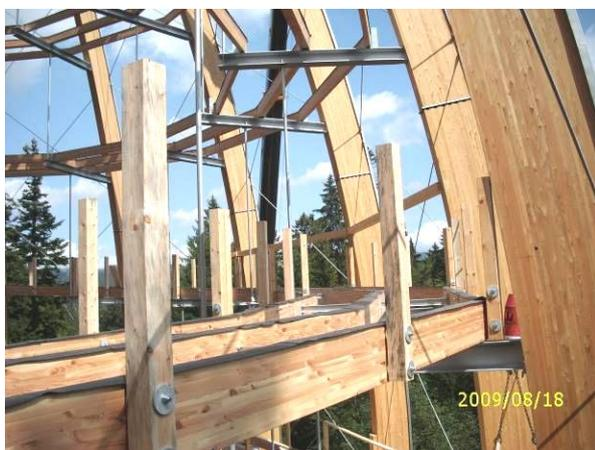
Abbildung 27: Montierte Bohlenträger mit Geländerpfosten
