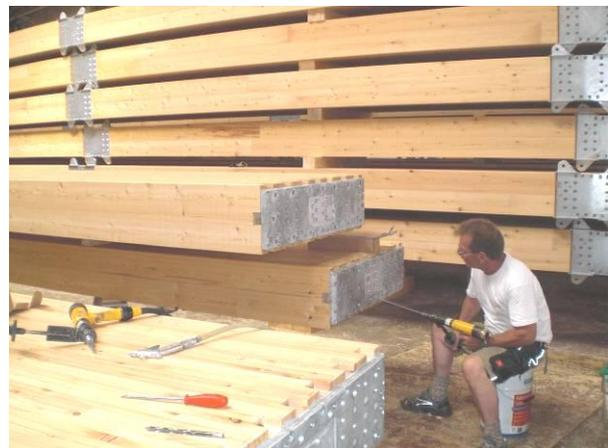
Abbildung 16: Elektronisch gesteuerte Einschraubgeräte
