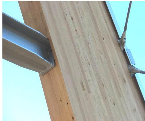
Abbildung 6: Anschlüsse in der Realität
