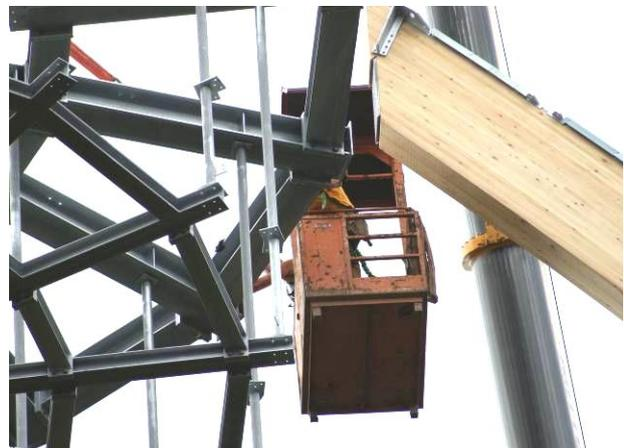
Abbildung 24: Anschluss Bogen an Plattform
