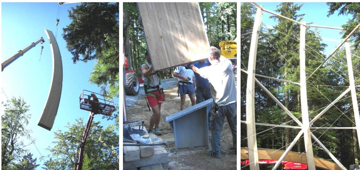
Abbildung 17, 18 und 19: Einheben, Montieren und Abspannen der ersten Bögen
