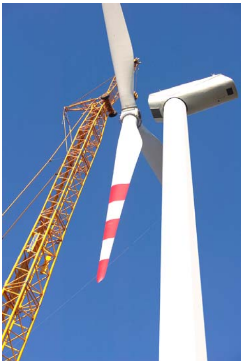
Abbildung 4: Rotormontage
