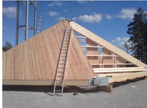
Abbildung 23 und 24: Vormontage 2D / Vormontage 3D Eckelement
