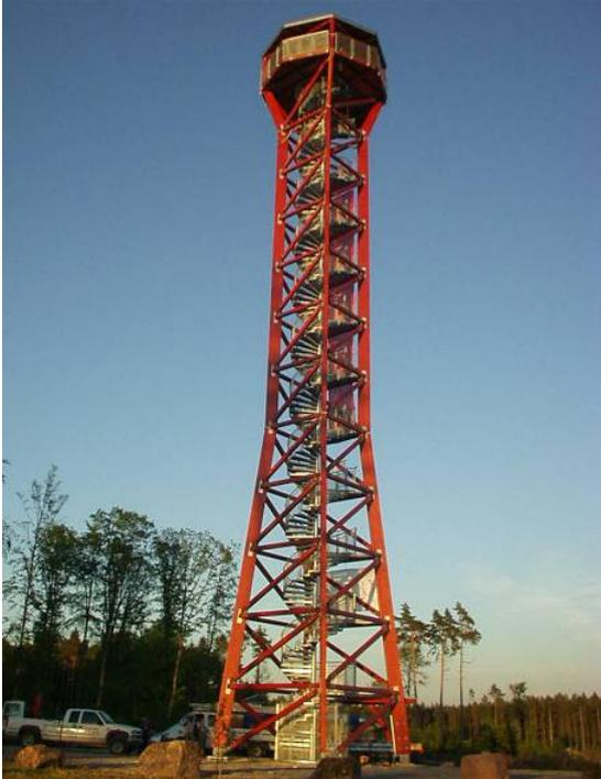
Abbildung 8: Turm Hohenwart Baujahr `99, Lärche BSH, gute Details aber „ungeschützt“
