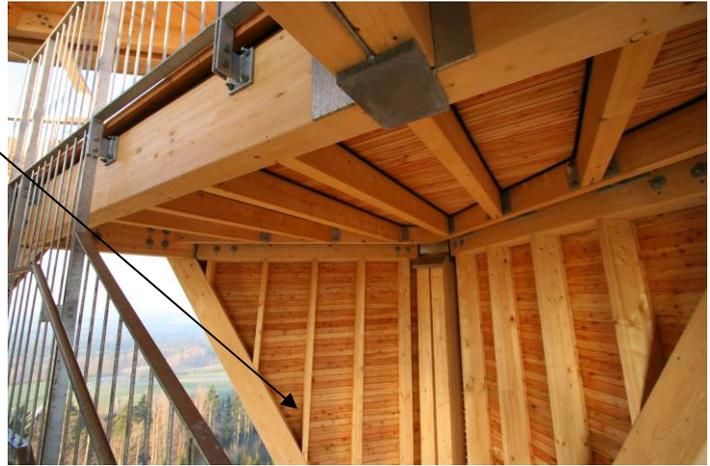
Abbildung 17: Schifter von unten
