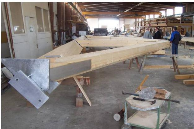
Abbildung 19: Vormontage Stahlteile und Segment
