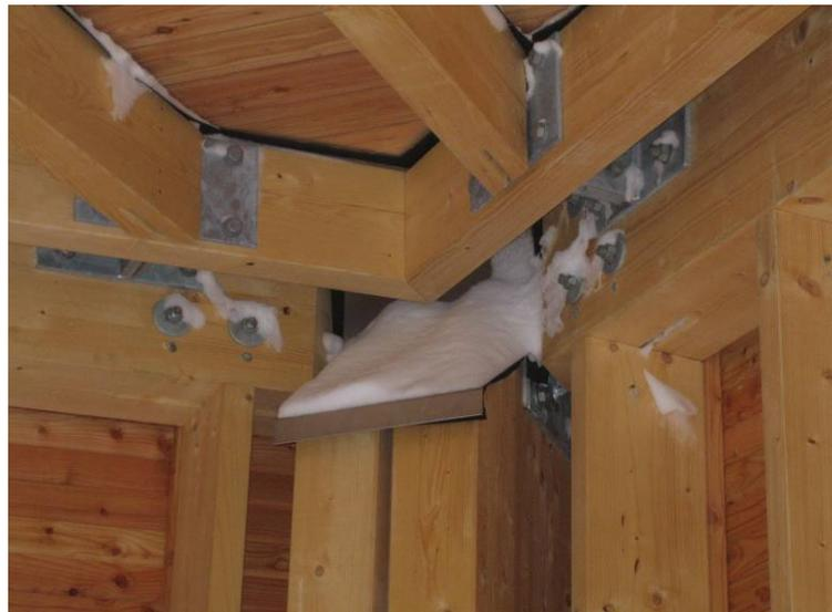
Abbildung 38 und 39: Detail Stoss mit Eiszapfen / Stützenenden unter Plattform
