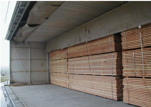
Abbildung 4: technische Trocknung in der Zu- und Ablufttrockenkammer
