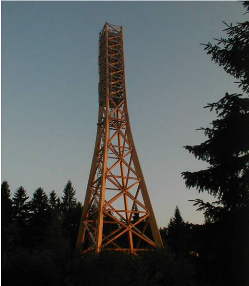
Abbildung 2: der fertige Richtfunk-Sendemast
