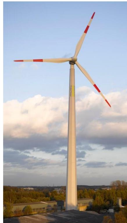
Abbildung 1: Prototyp TimberTower, Marienwerder/Hannover
