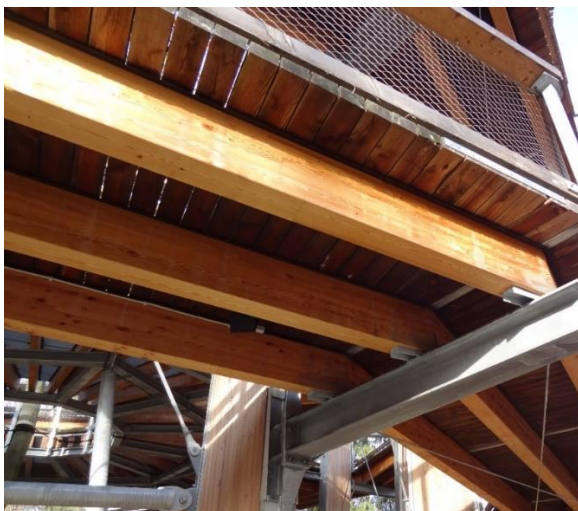
Abbildung 6: 60° – Regel richtig angewandt (von WIEHAG ausgeführt)
