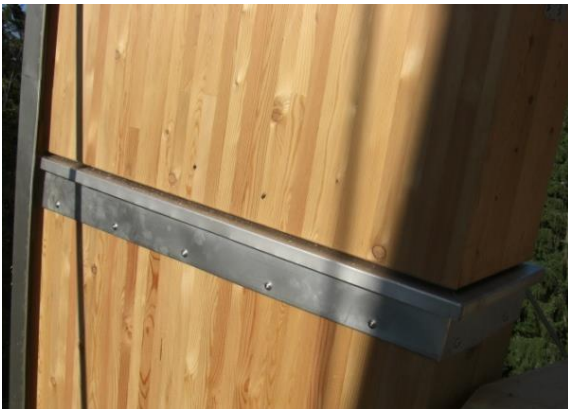
Abbildung 10: Korrekt ausgeführter Stützenstoß (von WIEHAG ausgeführt)
