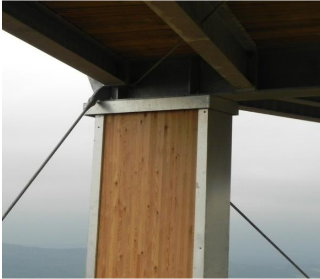
Abbildung 16: Stütze allseitig verkleidet (von WIEHAG ausgeführt)
