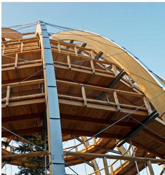
Abbildung 14: Abdeckungsregel konsequent angewandt (von WIEHAG ausgeführt)
