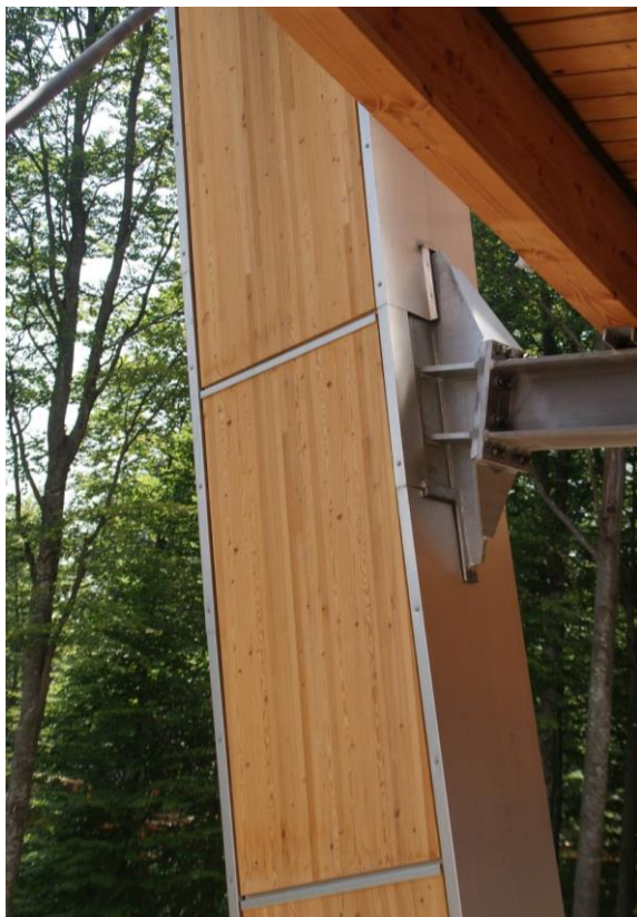
Abbildung 12: Korrekte Ausführung des Anschlusses (von WIEHAG ausgeführt)
