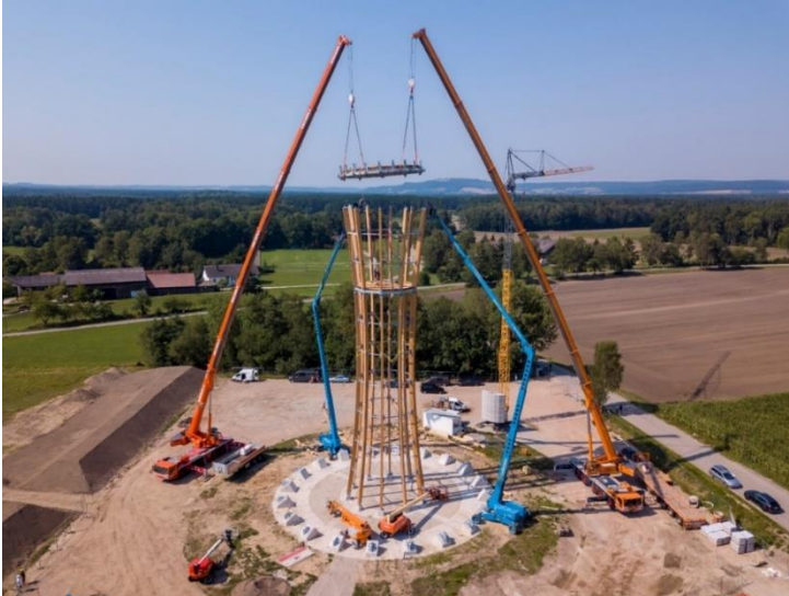
Abbildung 10: Tandemhubmontage oberes Podest Innenturm
