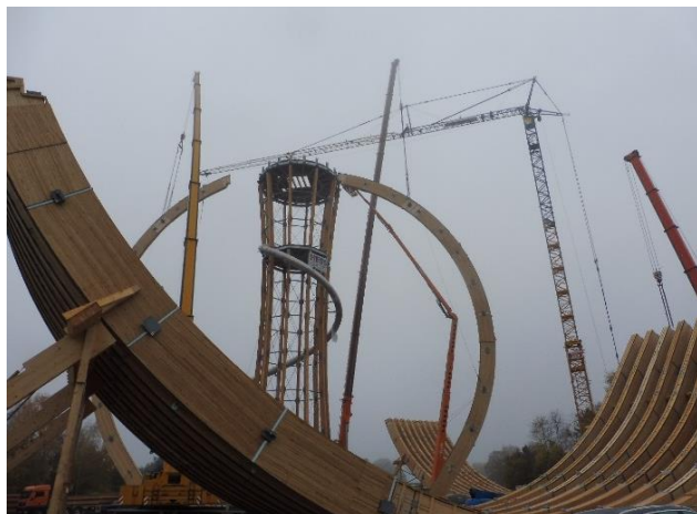
Abbildung 14: parallel versetztes Richten der Kugelbinder
