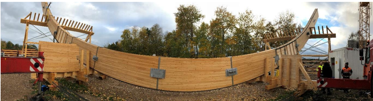
Abbildung 13: vormontierter Kugelbinder im Montagebock
