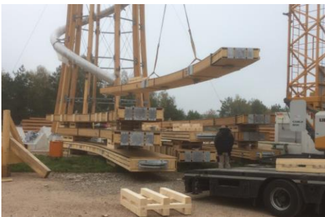
Abbildung 11: Zwischenlagerung Bogenbindersegmente auf der Baustelle
