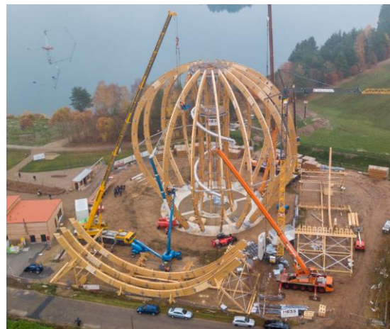
Abbildung 15: Montage Kugelbinder
