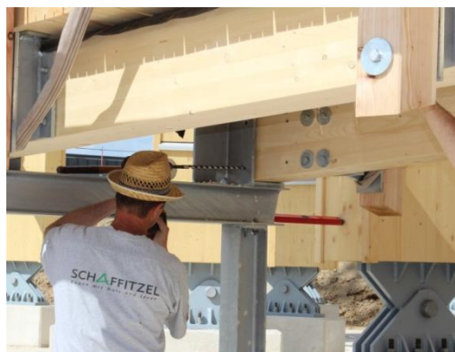
Bild 7: Präzision bis ins letzte Detail ist bei der Montage gefordert
