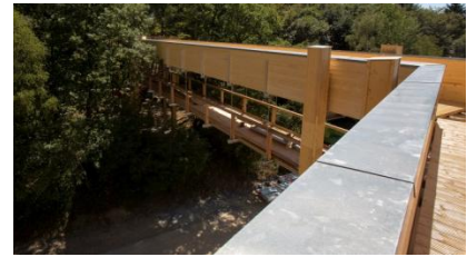
Bild 1: Zugangsbauwerk des Baumwipfelpfades
