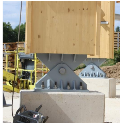
Bild 6: Stützenfußpunkt mit Brandschutzanstrich
